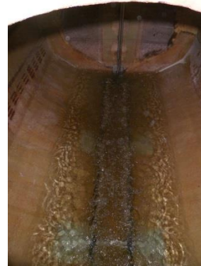
Transferencia de aire en interior de los tanques
